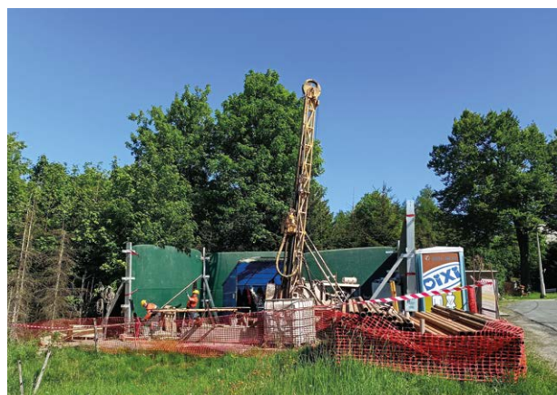
Abb. 4: Bohrplatz in Zinnwald (Sachsen) zur Erkundung des Lithiumvorkommens, Foto: Zinnwald Lithium GmbH (mit frdl. Genehmigung).
