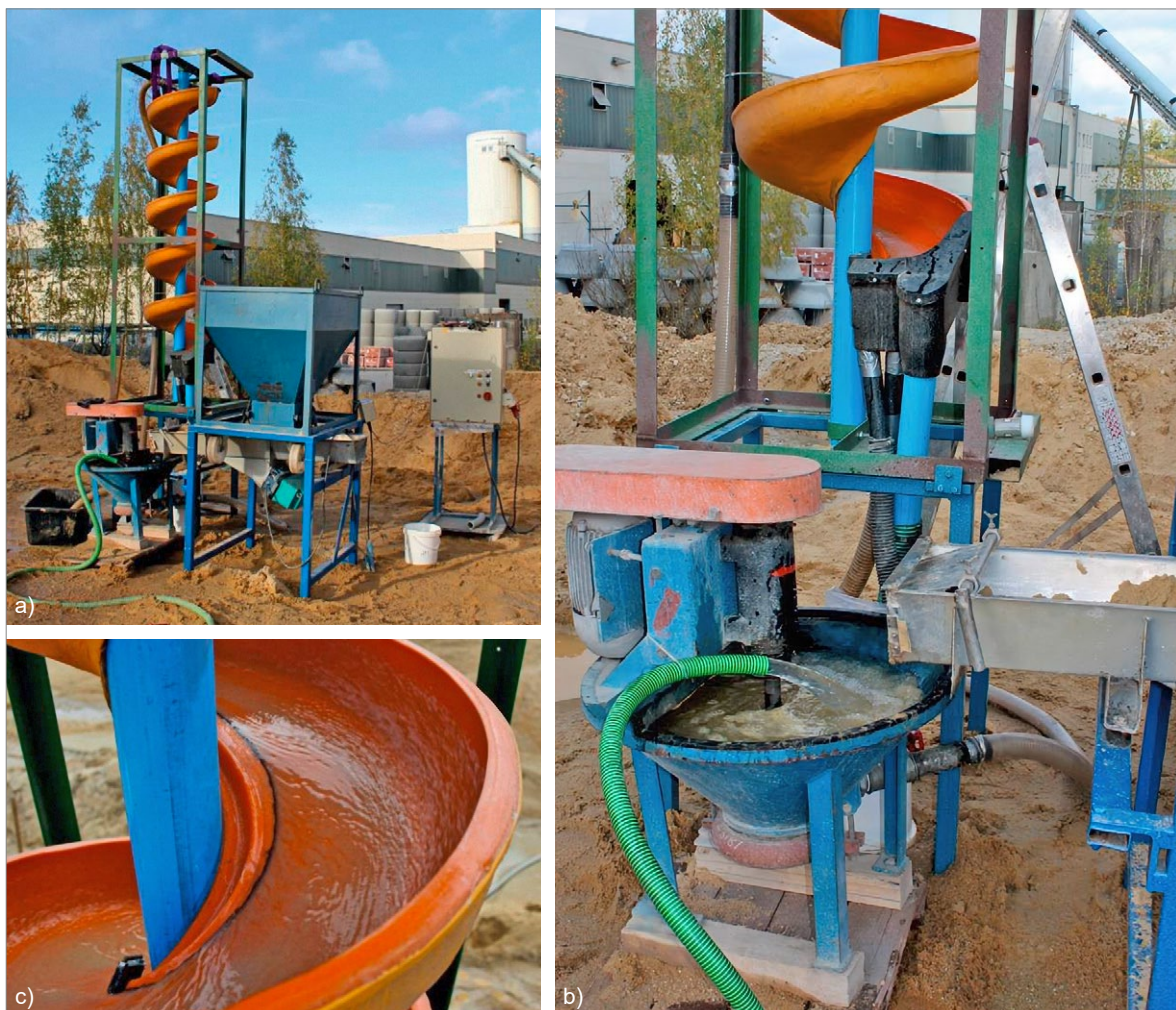
Abb. 5: Versuchsaufbau der Reihenprobenahme im Kieswerk 08/12
