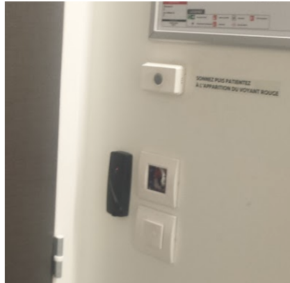
Photo 22: Exemple d'une fermeture extrême d'un espace de coworking – 2016 (source : personne)
